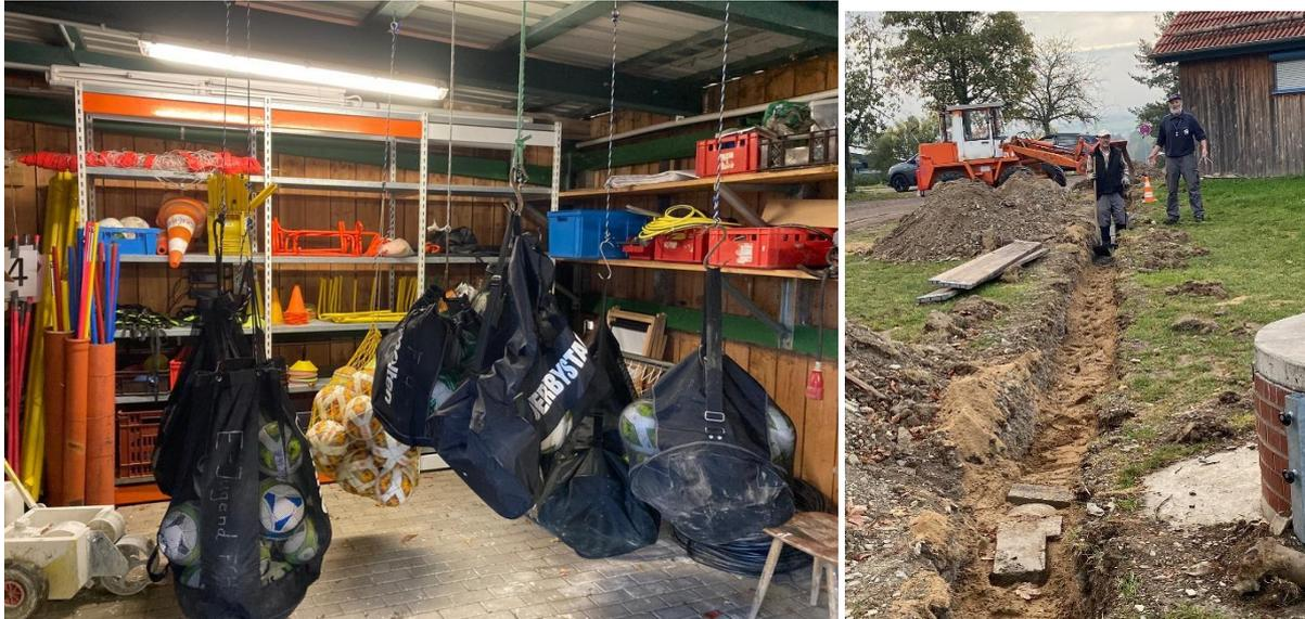
**Flutlichtkabel erneuert:** Und plötzlich war es dunkel im Herbst 2022. Die unteren 3 Flutlichtmasten waren stromfrei. Ein Kabelschaden. Die Kabelstrecke wurde zunächst durch ein Provisorium überbrückt. Es wurden im Oktober 150 Meter Kabelgraben ausgehoben, 350 Meter Kabel verlegt und angeschlossen.
